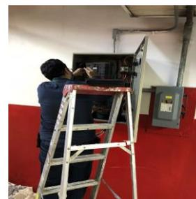
Detección y retiro de circuitos eléctricos indebidamente conectados en el almacén de reactivos.
